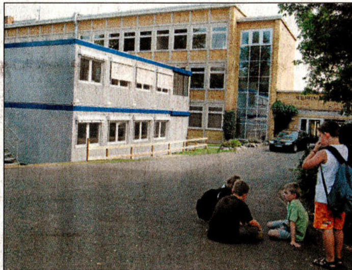
Baustellen-Alltag: Nach dem Abriss der Altbautrakte müssen Schüler der neunten und zehnten Klassen der WvO ab Montag auch mit Containern Vorlieb nehmen. (Foto: Weber)
